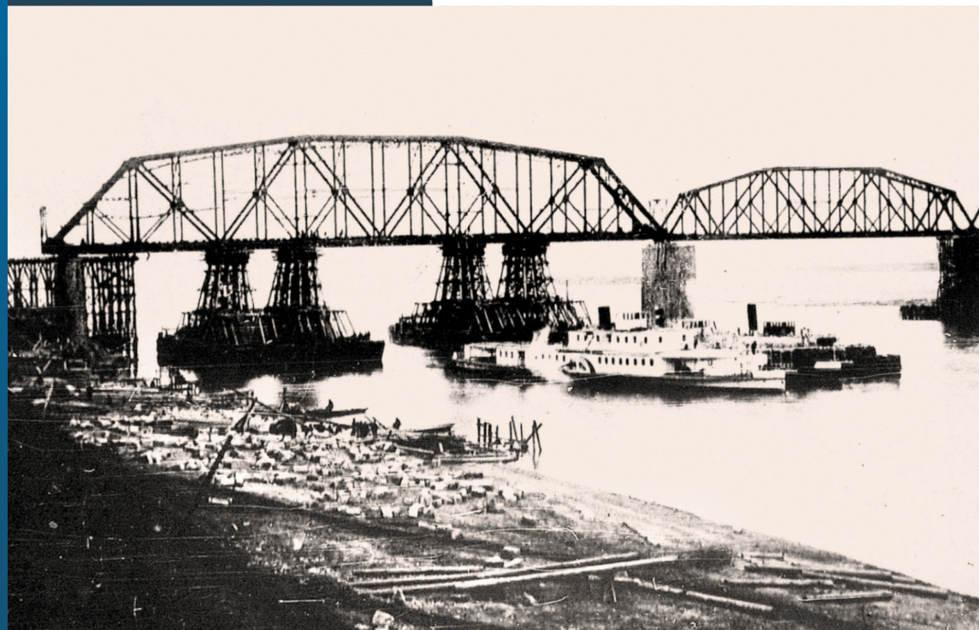
На линии Обь – Проектная был построен второй железнодорожный мост через реку Обь
