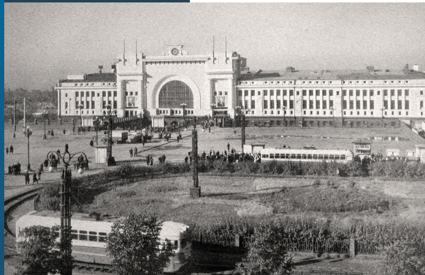
Вокзал станции Новосибирск-Главный
