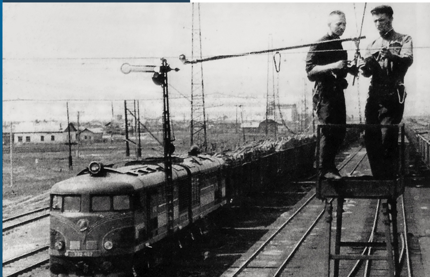
Работы по электрификации дороги
